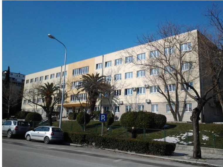
Slika 6. Zgrada Stomatološke poliklinike Split
