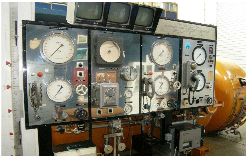
Slika 8. Pult za upravljanje barokomorom
